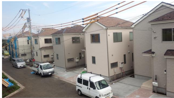
現地 F~J号棟側外観
